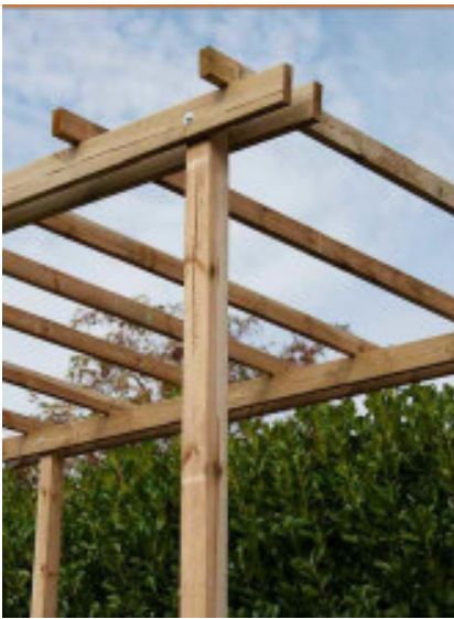
Area di sosta
